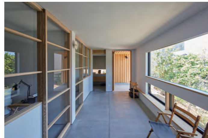
△1階の土間。冬は太陽熱を蓄え（ダイレクトゲイン）、夏は夜間換気で庭の冷気を蓄える（ナイトバージ）
