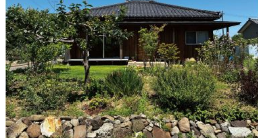
外構 外構は長閑な地域性を考慮し道路面に対して遮蔽性を低くし親密な雰囲気としている。
