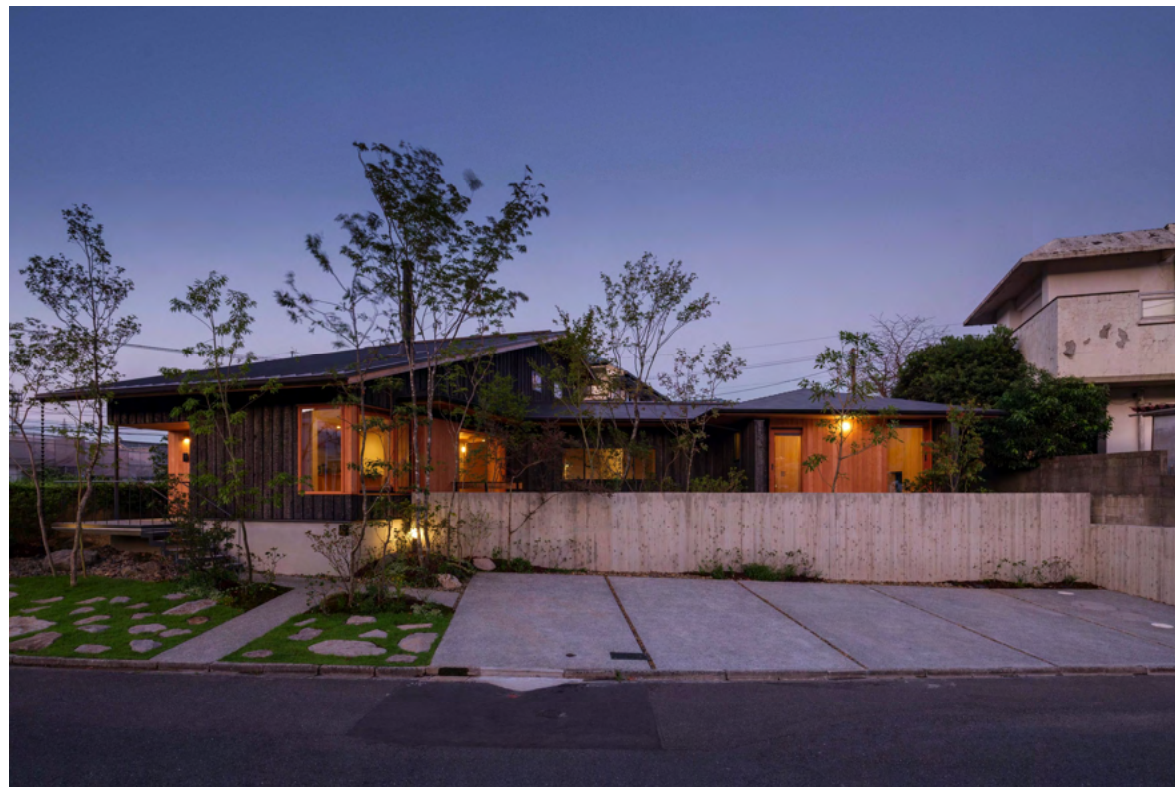
道路からの全景 台形の敷地形状を生かした配置・平面計画 向かって左手はLDKと吹抜けを通し見下ろす2Fテラス、右手の平屋部は寝室、浴室その間をデスクスペースでつなぐ
